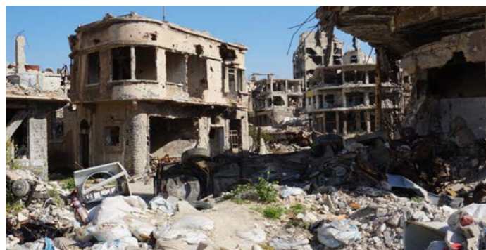
Zerstörte Gebäude in Homs
